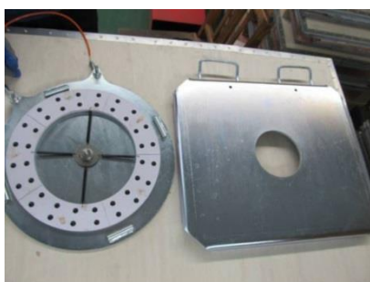
(Demontaż stalowej obrotnicy na dwie części)
