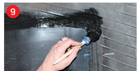
9 Pflastertrand versiegeln / 48 h Vulkanisationszeit Seal repair patch edges / 48 h curing time
