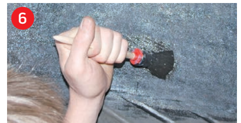
6 Geraute Fläche doppelt mit Cement einstreichen Coat buffed area twice with cement
