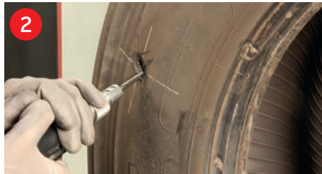
2 Corde zurückschleifen / Schadenstrichter konkav ausarbeiten Grind back the cord / work-out the injury to a concave shape
