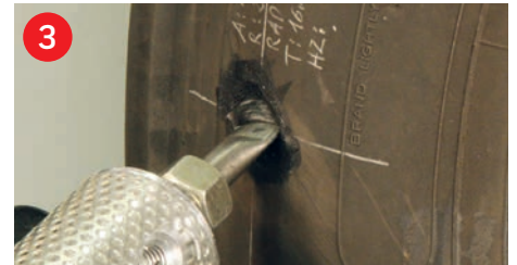
3 Schaden verfüllen und vulkanisieren Fill injury und vulcanize
